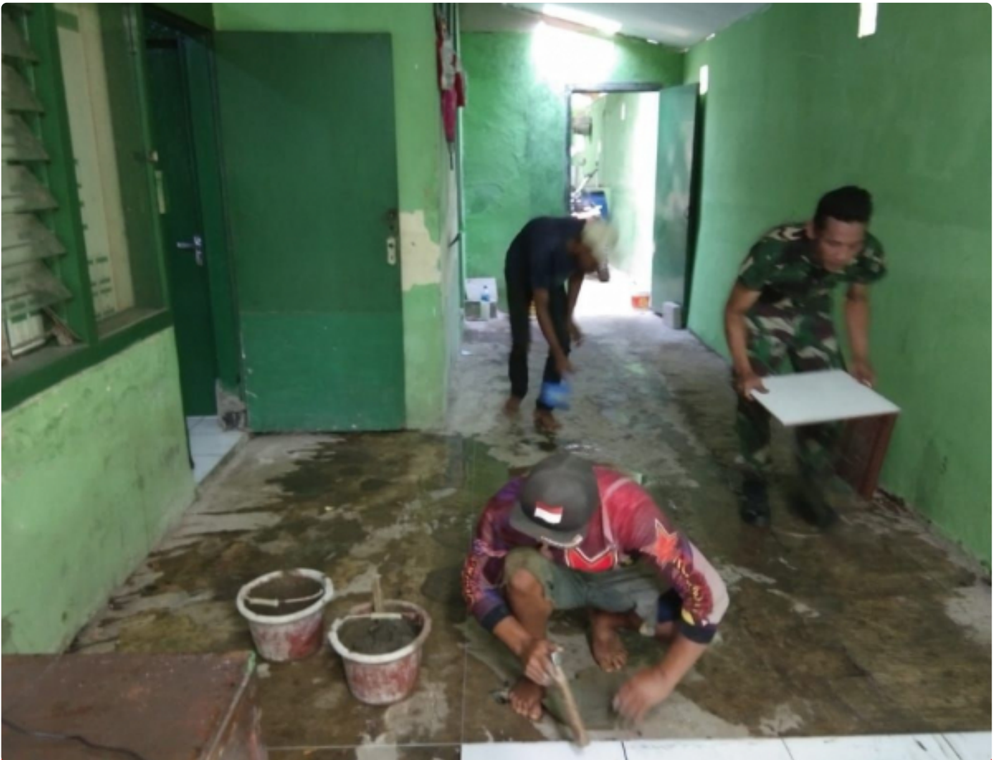
Koramil 0622-04/Cikidang Lakukan Perbaikan dan Pemeliharaan Kantornya
